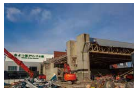
新総合体育館と解体中の旧総合体育館
