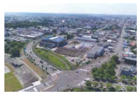
新総合体育館基礎工事中
