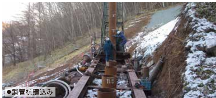
●鋼管杭打設全景
