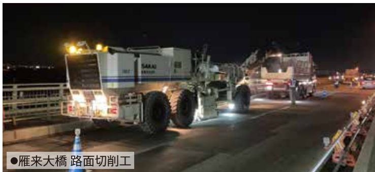
●雁来大橋 舗装打換え工
