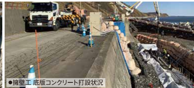
●重機用足場工 大型網かご布設
