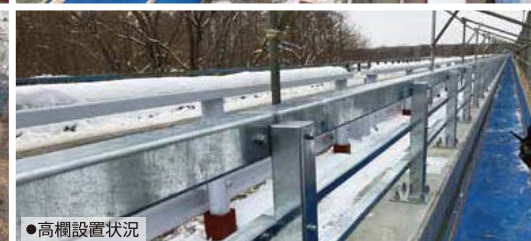
●高欄設置状況
