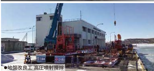
●地盤改良工 高圧噴射攪拌
