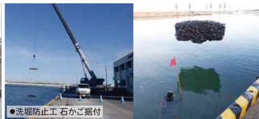
●洗堀防止工 石かご据付
