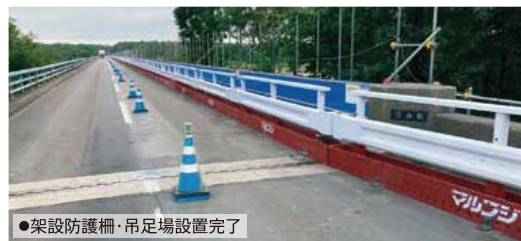
●架設防護柵・吊足場設置完了
