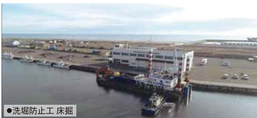
●洗堀防止工 床掘
