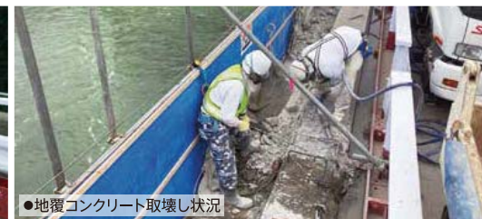
●地覆コンクリート取壊し状況
