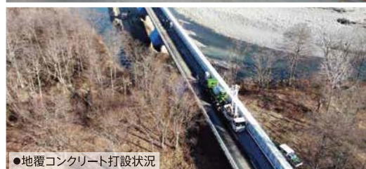
●地覆コンクリート打設状況
